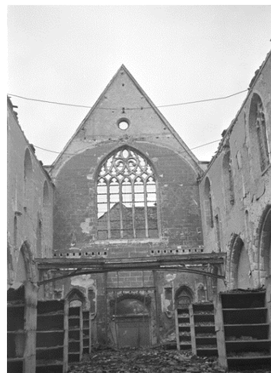
Vue du bâtiment des Archives départementales après les bombardements de juin 1940, tirages photographiques, collection Daniel Joseph (Arch. dép. du Loiret, 28 Fi 890)
