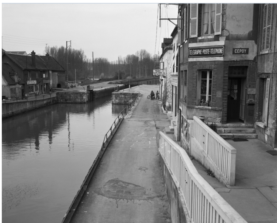
Cepoy - Maison au bord du Canal (CI-vue 14598)
