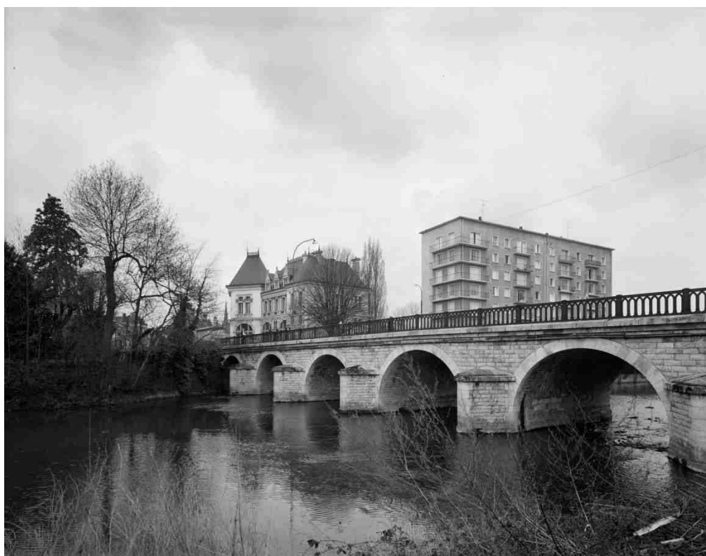
Montargis, Caisse d'épargne (Cl-vue 11345)
