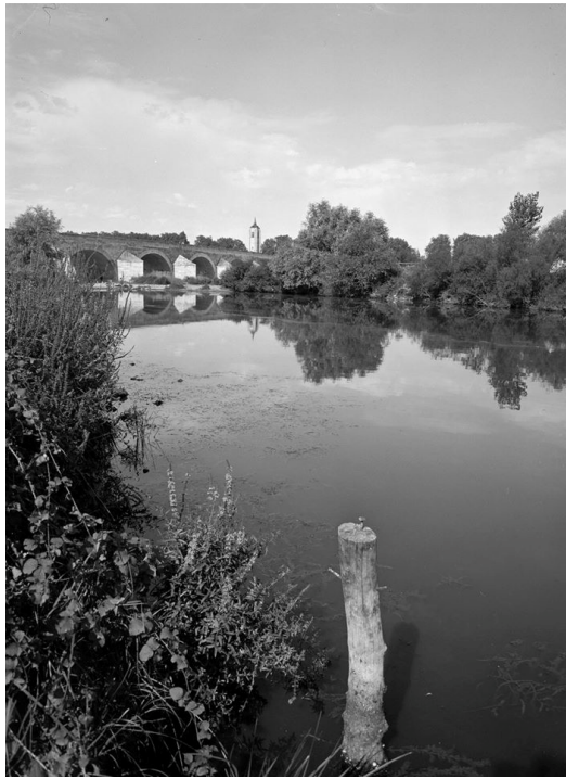
Pont de Beaugency -Cliché-vue 118
