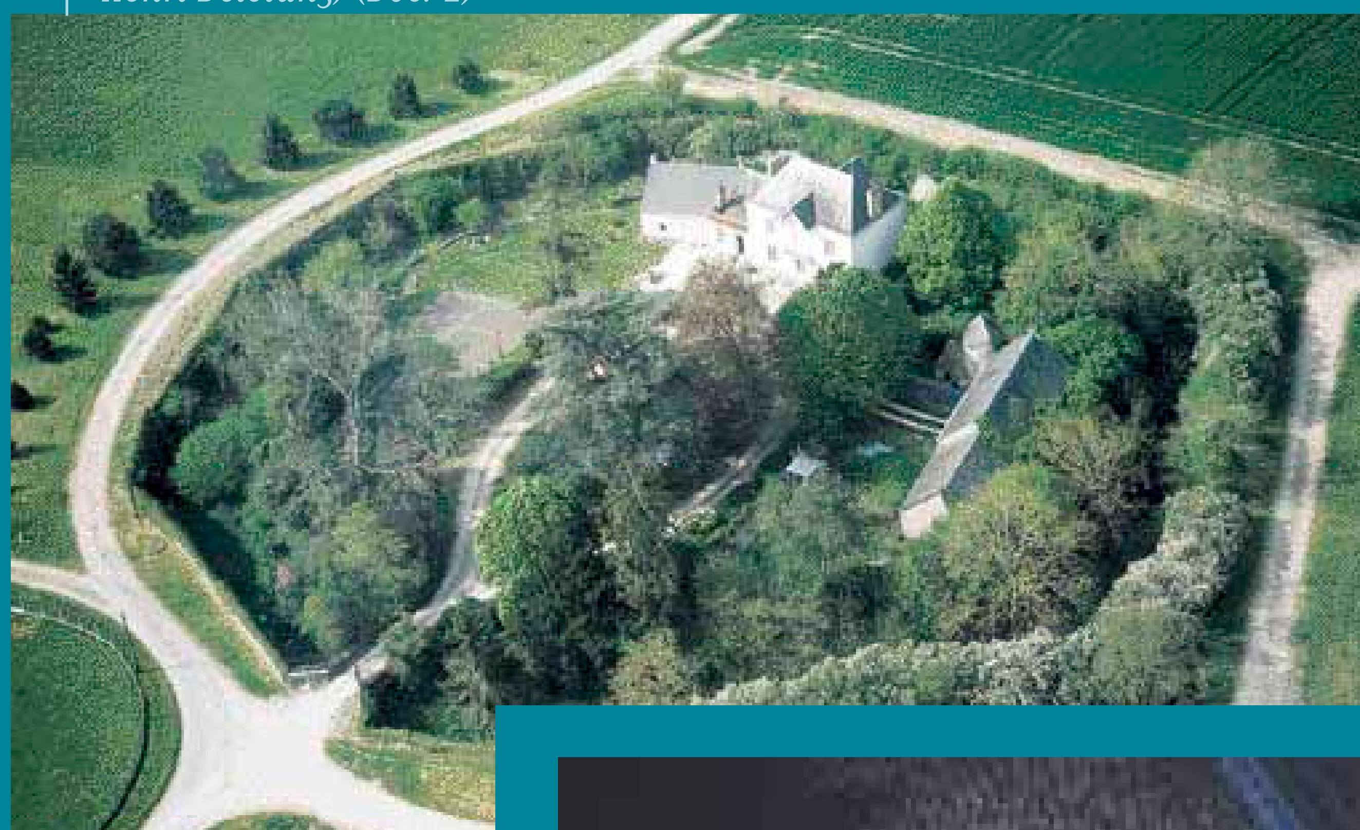
Vue aérienne de la motte de Huisseau-sur-Mauves (DRAC Centre/ cliché Henri Delétang) (Doc. 2)
