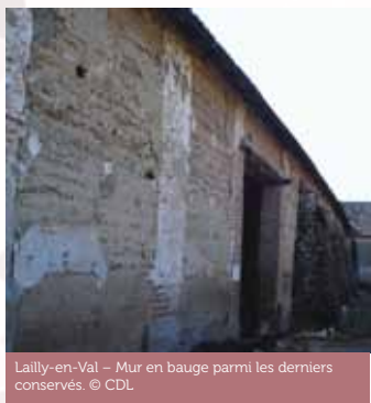
Lailly-en-Val – Détail des baugées. © CDL
