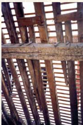
Briare - Réutilisation de bois de sapine (bateau de transport) dans la charpente. © C.Gavillon
