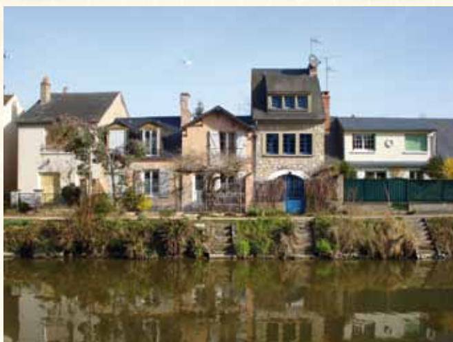
Combleux - Les escaliers relient directement les maisons de mariniers au canal. © CDL
