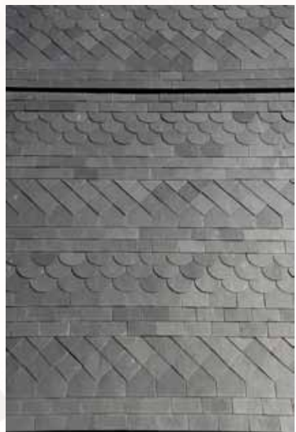
Meung-sur-Loire - L'utilisation de l'ardoise permet de réaliser des travaux d'une grande finesse, même sur des surfaces irrégulières ou au profil complexe. © CDL
