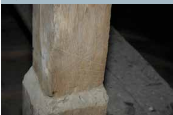
Marque de montage : ces inscriptions sont gravées à l'aide d'une rainette sur le pied des pièces de bois. Elles permettent au charpentier de connaître leur exacte position dans la charpente lors du montage. © ADL, F. Meunier
