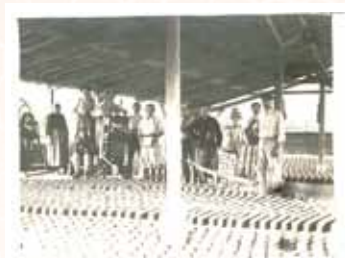
Marcilly-en-Villette – Briquetiers d'Alosse et briques crues disposées pour le séchage sous le hangar, carte postale. © Musée de l'Artisanat Rural ancien, Tigy, cliché CDL
