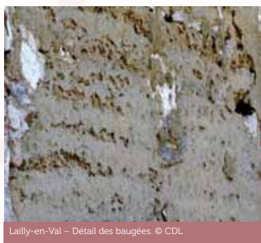
Lailly-en-Val – Mur en bauge parmi les derniers conservés. © CDL
