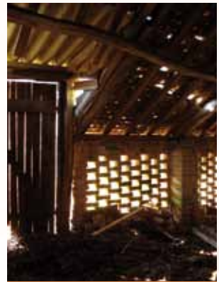
Marcilly-en-Villette – Système d'aération en brique. © CDL
