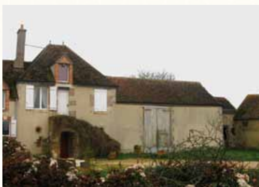
Ouvrouer-les-Champs - Le perron surelevé trahit la présence d'une cave semi-enterrée. © CDL
