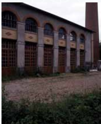
Fay-aux-Loges – Centrale électrique dite usine élévatoire. Cliché Hermanowicz, Mariusz © Région Centre Inventaire général, ADAGP (1996)
