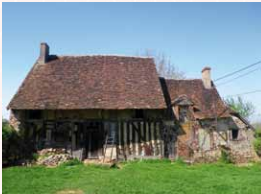
Triguères - Rare maison à pans de bois avec ajout en silex postérieur à la construction. © CDL
