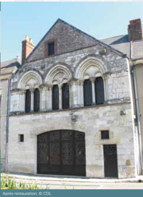
Après restauration. © CDL
