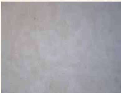
Boiscommun Enduit à la chaux avec traces de lissage à la taloche. © CDL
