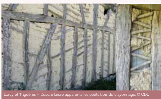
Lorcy et Triguères – L'usure laisse apparents les petits bois du clayonnage. © CDL
