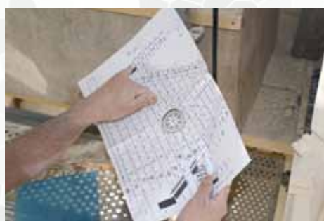
Le travail de pose est réalisé à partir du « calepin », plan de numérotation de chaque pierre. © ADL, L'Volland
