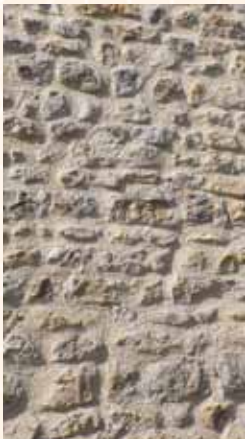
Erceville - Enduit à pierres vues. © CDL
