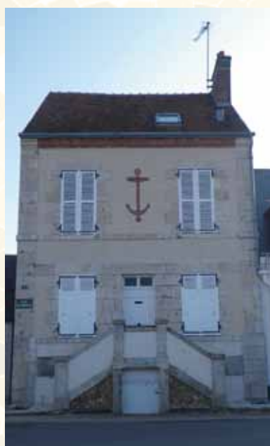
Sully-sur-Loire - Placé face au fleuve, l'édifice arbore l'emblème de la marine de Loire. © CDL
