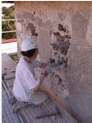
Démontage partiel de maçonnerie et piquetage des enduits puis des joints. © INRAP, V.Mataouchek
