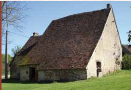
Le grès, roche dure issue de la consolidation de sable très présente en Gâtinais, peut être utilisé en chaînage d'angles. © CDL
