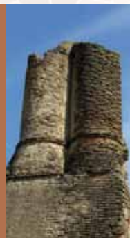
Saint-Florent Surprenantes et rares cheminées rondes en briques cintrées typiques de Sologne. © CDL
