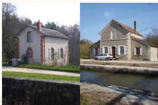
Combreux et Ouzouer-sur-Trézée - Les maisons éclésières du Moulin rouge et du Petit Chaloy illustrent la standardisation de l'architecture. © CDL
