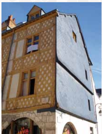
Orléans - L'ardoise peut aussi être utilisée en bardage sur un édifice, pour protéger une façade des intempéries. © CDL
