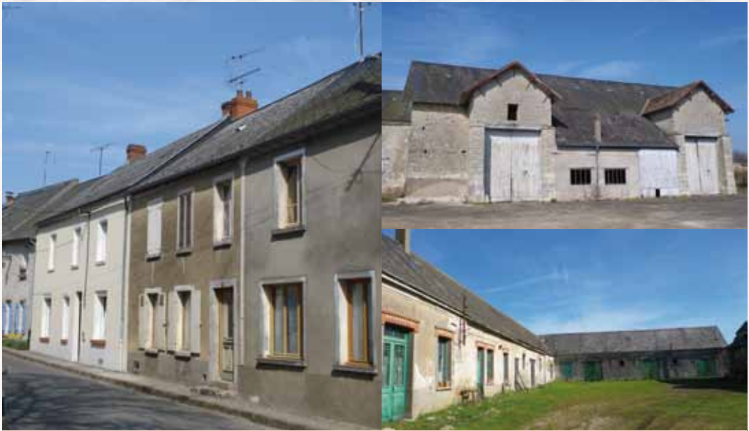
Erceville, Boisseaux et Mainvilliers - Particulièrement répandue dans le nord est du département, l'ardoise couvre une majorité des toits des villages de Beauce. © CDL
