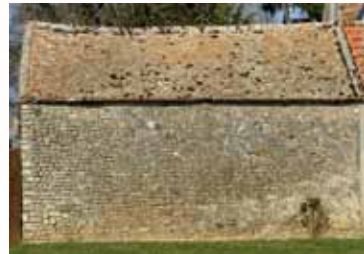
Autrui-sur-Juine – Toit en bâtière jadis adapté à la couverture en chaume. © CDL
