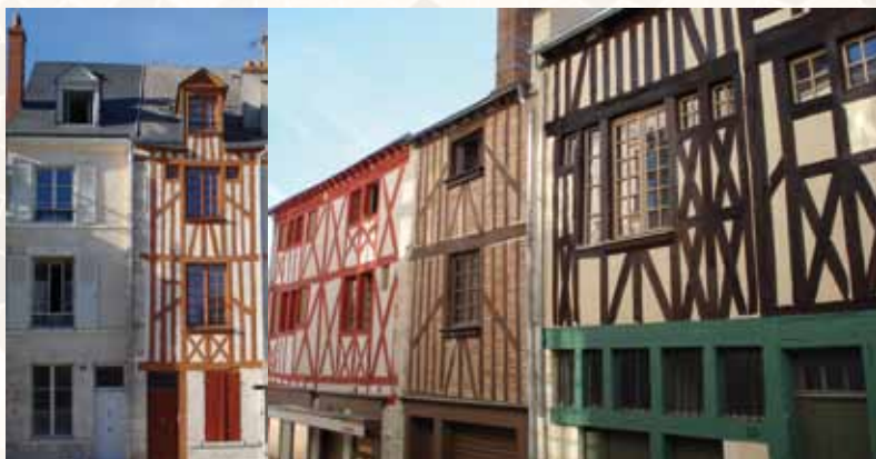
Orléans - Au XIX e siècle, les pans de bois des anciennes maisons ont souvent été masqués par de l'enduit. Ces constructions sont progressivement restaurées et valorisées. © CDL
