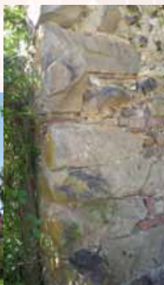
Le grès, roche dure issue de la consolidation de sable très présente en Gâtinais, peut être utilisé en chaînage d'angles. © CDL
