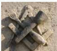
Aulnay-la-Rivière – Linteau de porte avec outils de tailleur de pierre (massette, gradine, equerre et compas). © CDL
