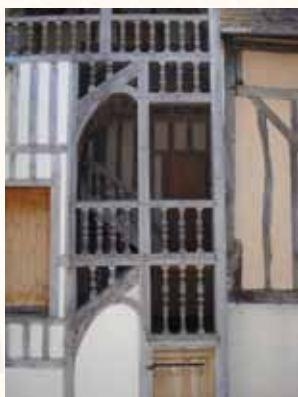
Château-Renard - Maison des notaires dont l'escalier a été restauré en 2006. © CDL
