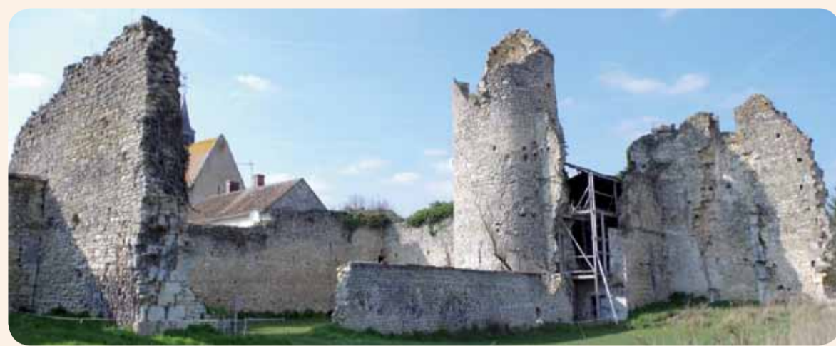
État actuel de la maison-forte de la Neuville-sur-Essonne, 153 Grande Rue
