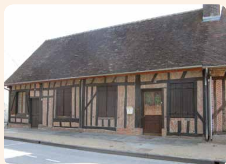
Maison en brique et en bois - ©Conservation Départementale du Loiret • Cerdron
