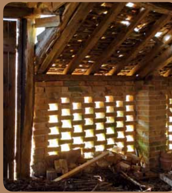
Détail du système de ventilation d'un séchoir du XIX e siècle construit en terre cuite architecturale - ©Conservation Départementale du Loiret • Marcilly-en-Villette
