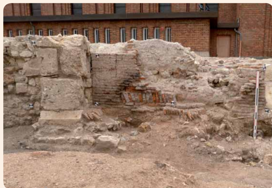
Âtre sud de la double cheminée renaissance de la tour seigneuriale : les deux âtres situés de part et d'autre du mur permettent de chauffer deux pièces en n'utilisant qu'un seul conduit • Château de Gien, Belvédère ouest
